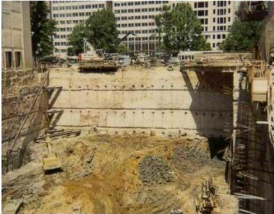
图 2.1 锚杆地连墙支护
